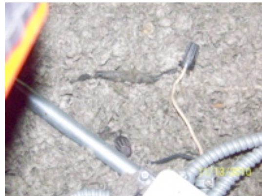
live knob & tube wiring
